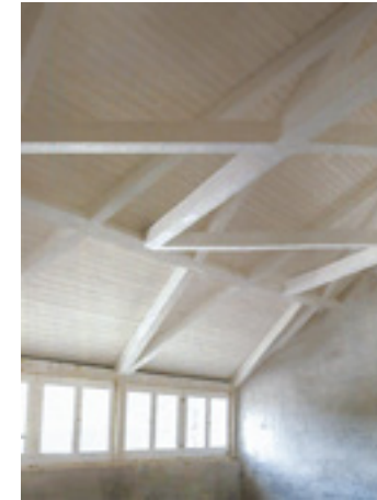
→ Paks, Bezerédj Általános iskola elburkolt tetőszerkezete (Fenes Tamás fotója)
