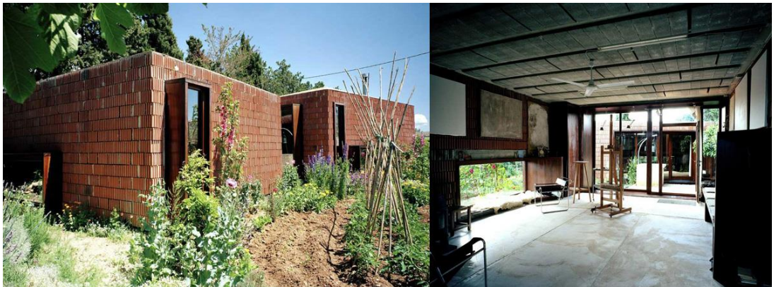
Francisco Cifuentes célszerűsége kihegyezett formaalakítása. A térelhatárolás megalkotása során alapvetésnek tűnik, azoknak a gesztusoknak az eltávolítása, melyek a hagyományos építésben a legelemibb építést meghatározó elemeket elfedik. Nincs vakolás, csak a puszta fal.
