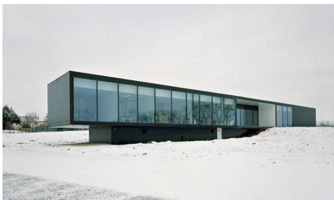
Saint Mesmes Marchesini Irodaépület /Lan Architecture
