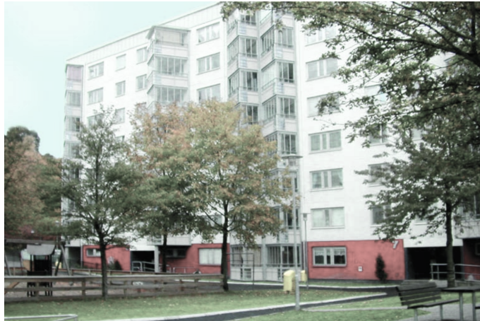
kép forrása: Novák Ágnes: Panelfelújítás vagy panelrehabilitáció? in: Építőmester 2006. május június. 22-24.
