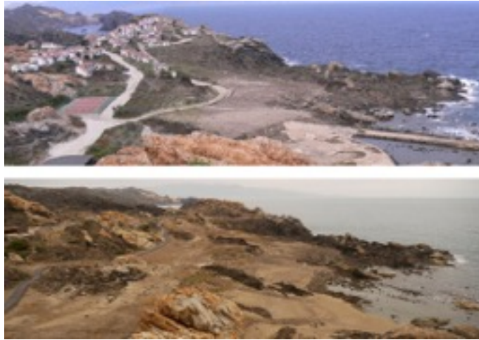
Tudela-Culip Restoration Project, beavatkozás előtti és utáni állapot képei
