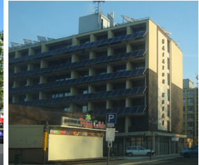
2014 szintenként napelemsor a homlokzaton
