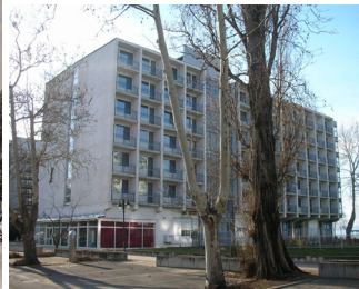
2011 földszint teljesen beépült fém erkélykorlátok
