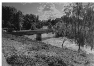
Híd és vízköpő
