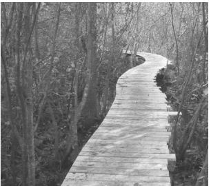
A Half Mile építés közben. A deszkák túlnyúló, szabálytalan végeit később levágták.
