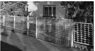
Tipikus, vágás utáni maradék acél elem felhasználásával készült kerítés egy kockaház előtt Tatabányán.
