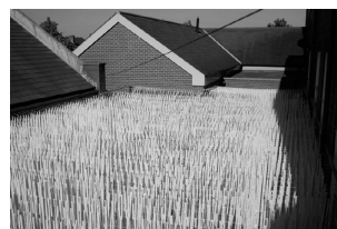
09. Dale School - From a Void to a Volume of Possibility - 2006-2009 Meglévő iskola bejáratának és belső udvarának átalakítása 3 éves kutatás folyamán az iskola használóinak bevonásával (tanulmányút Pistoia-ba, Reggio Emilia) - MUF Architecture Art
