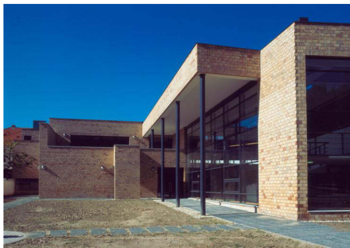
Az épület bejárata a Lajta (park) felől
