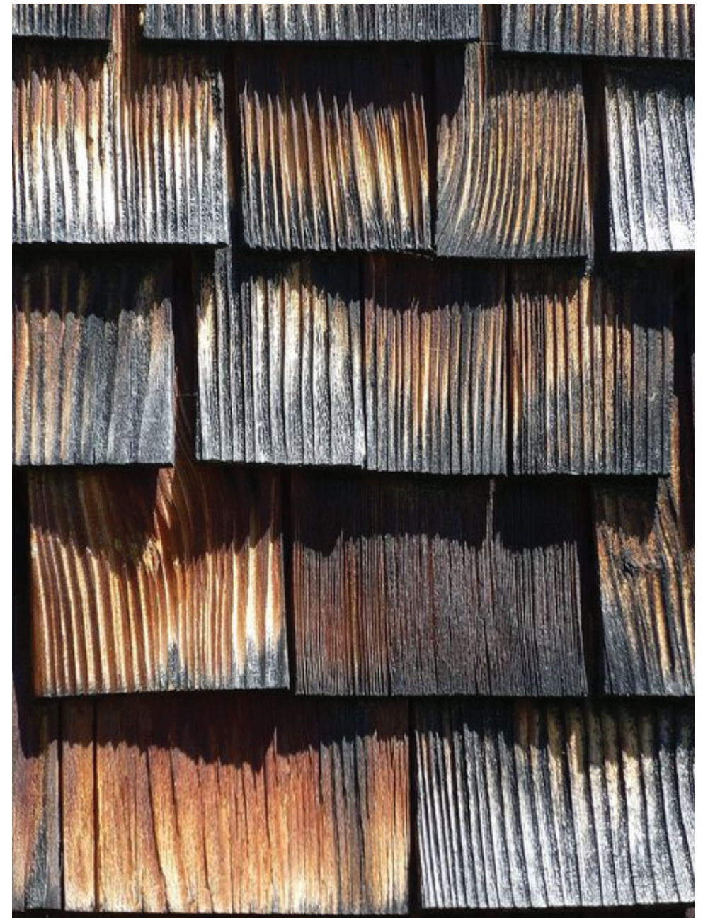
• Caplutta Sogn Benedetg Homlokzati részlet. Forrás: Peter Zumthor
