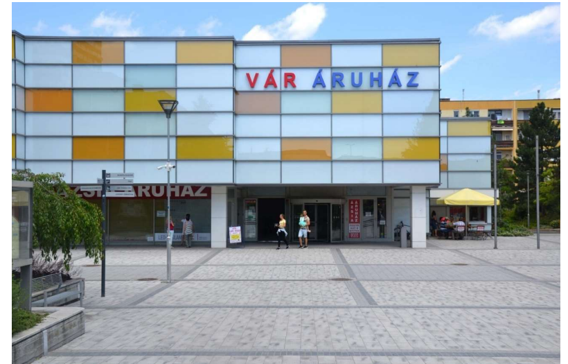
22. A megújult Vár Áruház tér felőli homlokzata
