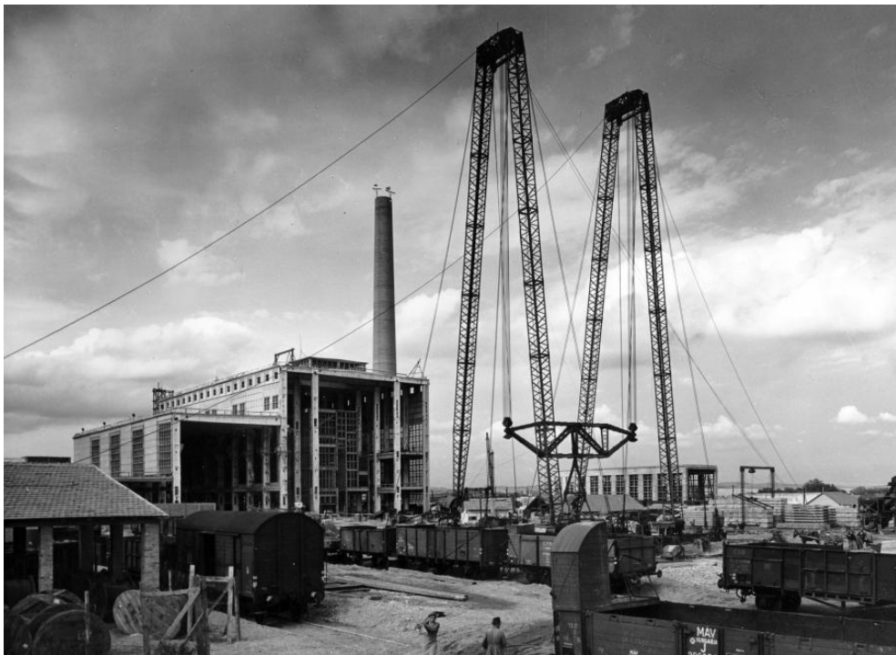
29. A berentei erőmű építése az 50-es években, helyszínen „előregyártott” technológia alkalmazásával. Fotó forrása: www.fortepan.hu
