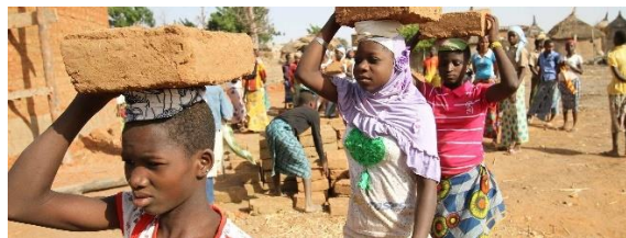
30. Helyiek részvétele az építési munkákban, Gando
