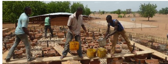
32. Helyiek részvétele az építési munkákban, Gando
