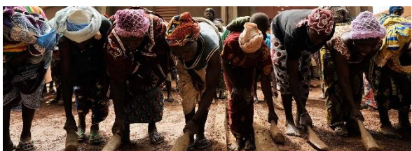
31. Helyiek részvétele az építési munkákban, Gando
