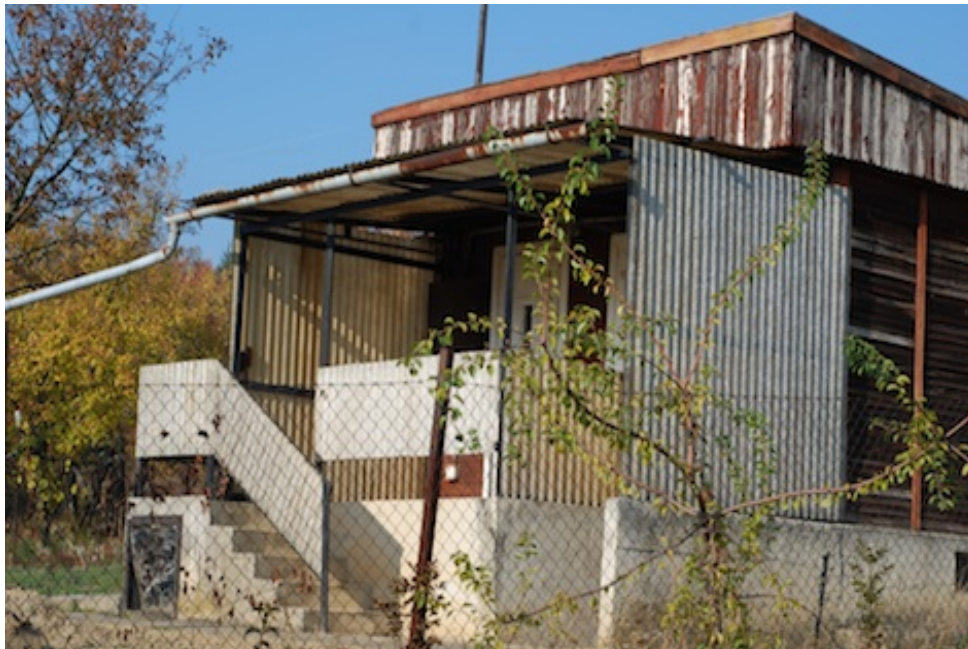
n073 - Nyaraló Alsóörs külterületén: Feltehetően egy előregyártott faház lebetett a kiindulópontja, a fedett-nyitott tér igényeit biztosító hullámpala felületi játéka meglepően jól működik a fa osztás ritmusával. Az öregedés hasonló színeket csalt elő minden anyagból.
