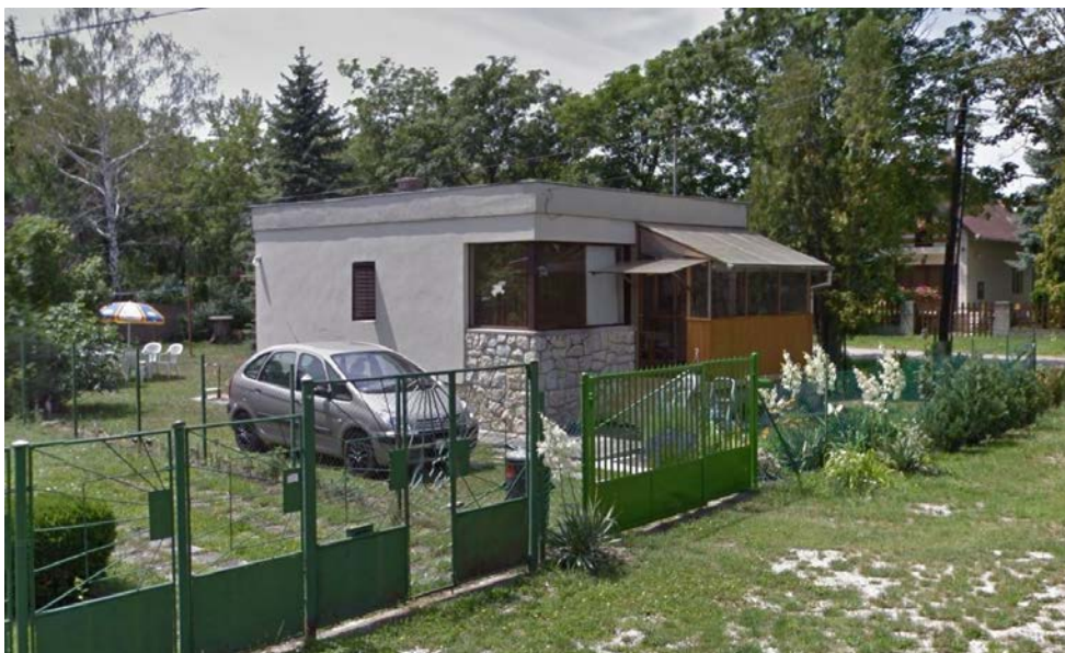
n060, Balatonudvari – Egyértelmű a modernista típusútervből való kiindulás, az eredeti ház verandájának beüvegezése után újabb elölető készült, annak beüvegezése után újabb elölető. A fedett-nyitott tér végül a kerti napernyő alatt találta meg a helyét.
