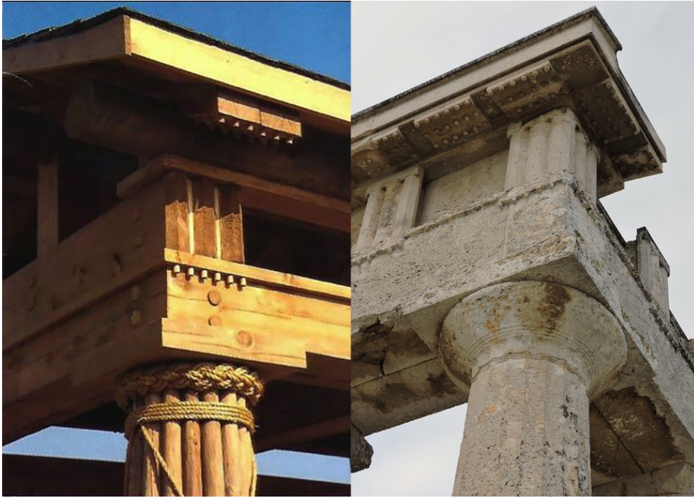
Dór oszloprend feltételezett fa előzménye, és a dór oszloprend anyagában átalakult változatával, ahogyan ma ismerjük, Aphaia templomán (Aeginában, Görögország)
