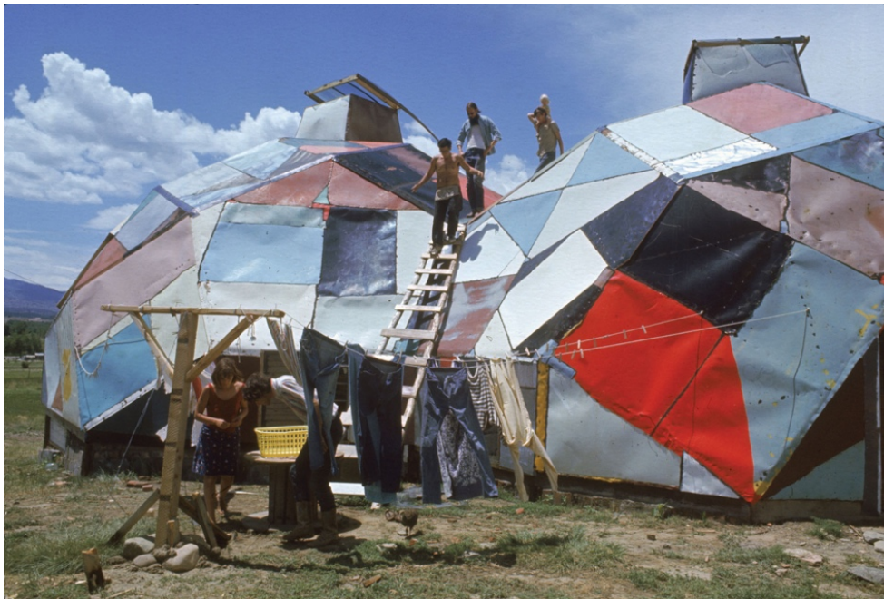
Drop City, Colorado USA, 1965-1970 Az hippimozgalom első kommunájának épületeit Buckminster-Fuller szerkesztése alapján, hulladékanyagokból, saját erővel építették fel a lakók
