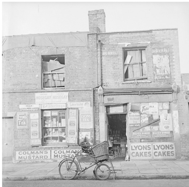
Streets – Nigel Henderson 1950. A Smithson házaspár „as found” teóriájának kiindulópontja: a fotókon a romokon, szegénységben felülemelkedő, burjánzó emberi lét építészeti megnyilvánulása. A képen rendszertelenül összerótt építőelemek, saját kézzel befoltzott ablakok: buherálás nyomai láthatók.
