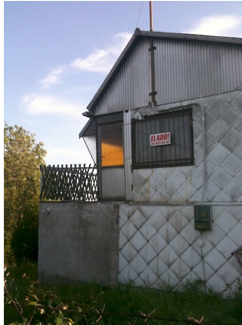
n069 – Balatonfüred: A különböző struktúrájú fém szerkezetek (ajtó, korlát, pikkely, bullámlemez), a vakolat és rajta az idő lenyomatai valószínűleg az építés különböző periódusait rajzolják ki, ezáltal sajátos és őszinte tektonikát adnak az épületnek
