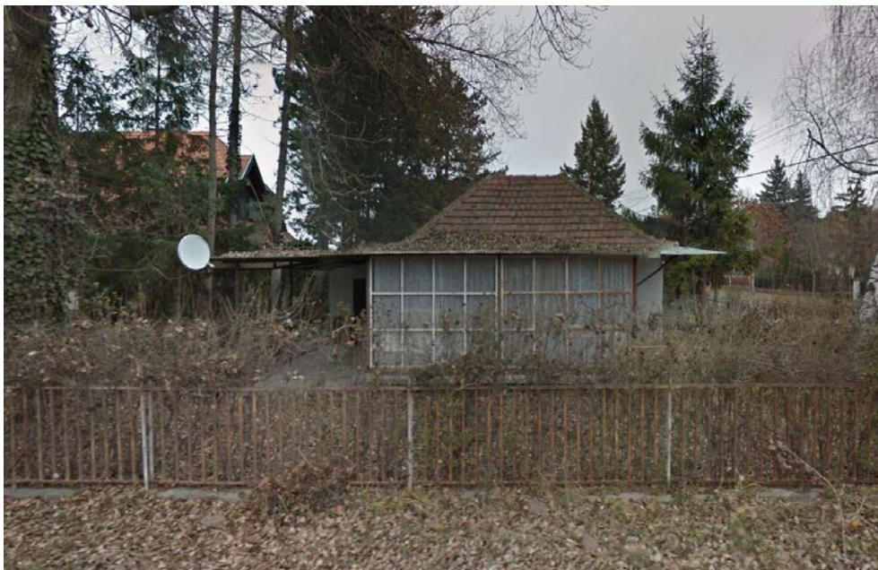
N082 – Balatonszabadi-sósfő – Ebhez apró, kontyolt tetős házhoz hozzáadott elemek kifejezetten harmonikus kompozíciót eredményeznek. Az elegáns négyzetes osztású üvegezett térelhatárolás, és a pengevékonyságú, nagy kiülésű, enyhény lehajló tetők sajátos bájjal ruházzák fel, egyúttal funkcionálisan is besegítenek a nyaraló használatába.
