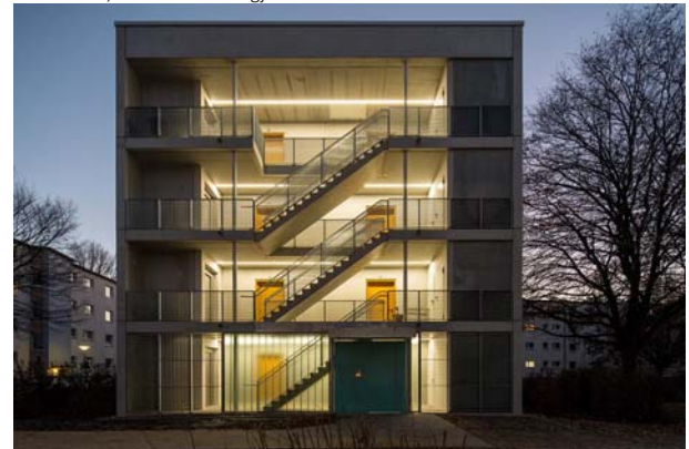
6. fotó - Egyik mintaépület északi homlokzata, termikus burkon kívüli közlekedő-, és merevítő magja
