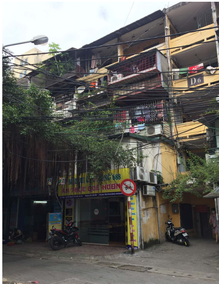
IV.43. Giảng Võ lakótelep, D6 épület, 212 lakás: kívülről
