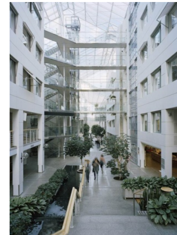
59. kép: Az épületrészeket a belső utca fölött összekötő hidak
