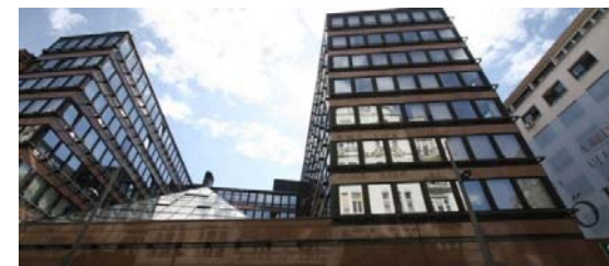
84. kép: OTP Chemolimpex - változtatások egy nagy múltú épületben
