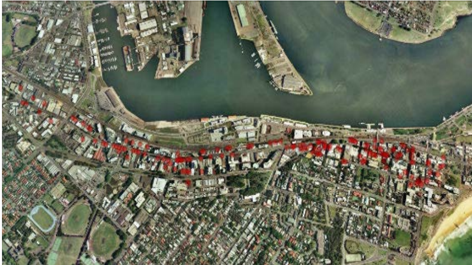
10. kép: Newcastle üzlettcája és a közhathasználattal megtöltött földszinti üzletek.
