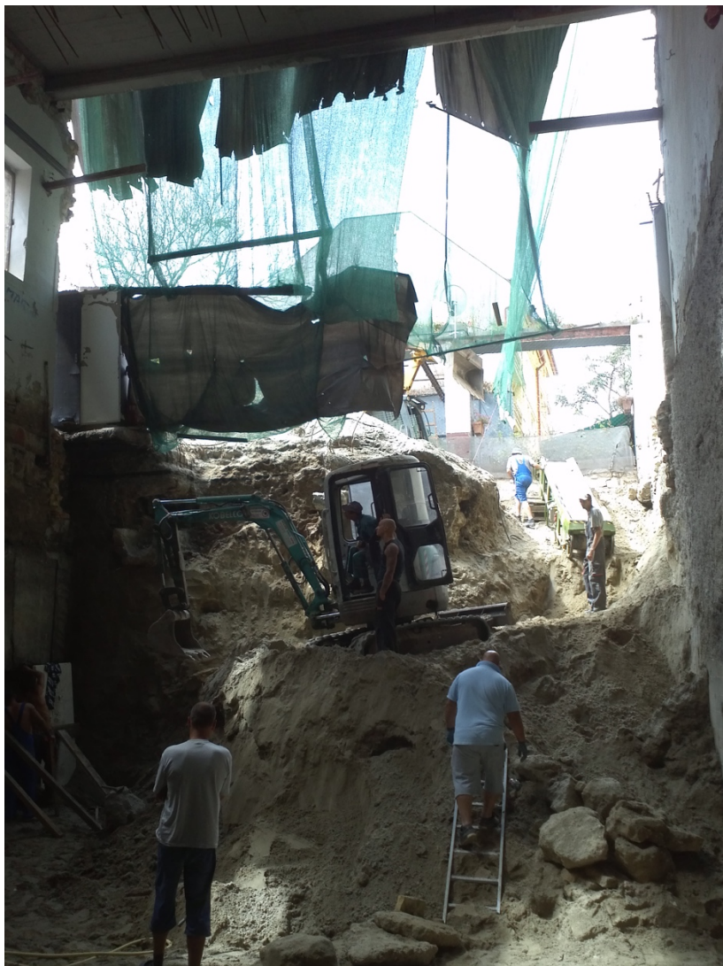
ábra 27 A Kocka föld alatti bővítése kapcsán folytatott alapozási munkálatok 2013. (fotó: Turai Balázs)
