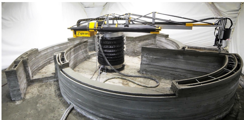
ábra 23 3D nyomtató - az épület nyomtatása közben - az Apis Cor nevű cég megvalósításában 2017.
