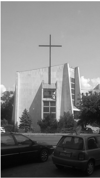
Budapest-Vizafogói Tours-i Szent Márton templom - nyugati homlokzat
