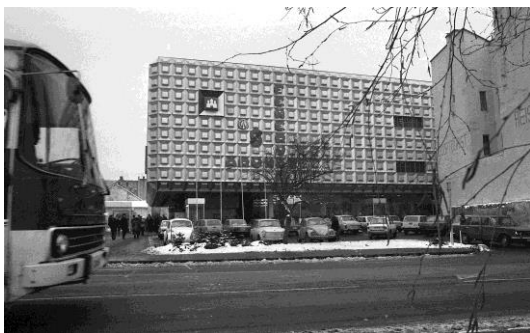
20. A szomszédos épület bontása előtt még beszorítottabb állapotban.
