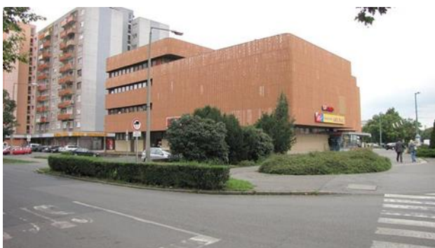
16. Az áruház és a mellette álló tízemeletes lakóházak.
