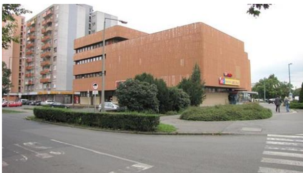
Az áruház és a mellette álló tízemeletes lakóházak.
