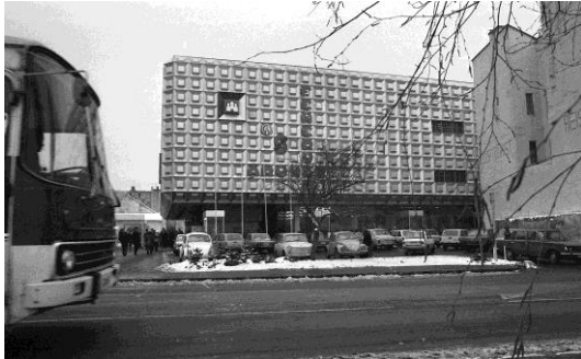
A szomszédos épület bontása előtt még beszorítottabb állapotban.
