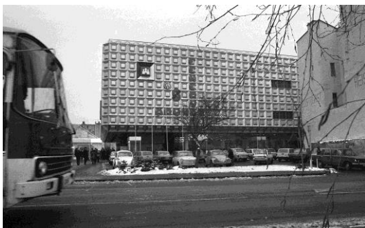
A szomszédos épület bontása előtt még beszorítottabb állapotban.
