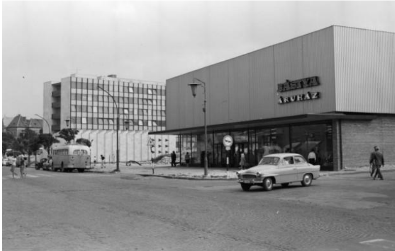
A veszprémi Bástya Áruház a megépülésekor még gépkocsival is járható Kossuth Lajos utca felől.
