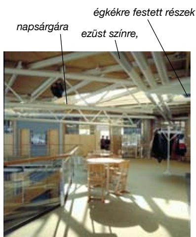
Az őszintén megmutatott, barkácsoltnak ható acél rácsostartót a fehér alapszín könnyedebbé, a bizonyos helyeken spontánul használt ezüst, égbé és napsárga színek pedig emberközelibbé teszik. (Hauptschule Lorch, 1982)
