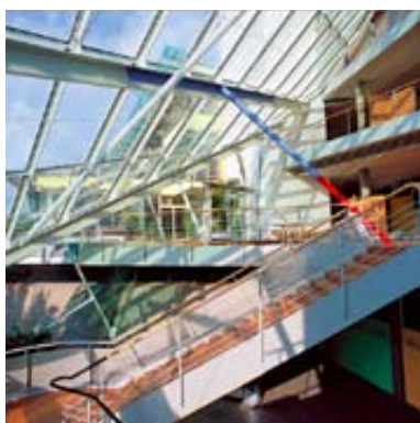
Az 1996-ban megvalósult drezdai St Benno Gimnázium aulája.
