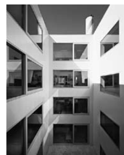
A basel-i Volta-iskola emeleti alaprajza és az egyik belső udvar nézete (megvalósulás éve: 2000; tervező: Miller & Maranta, Basel)
