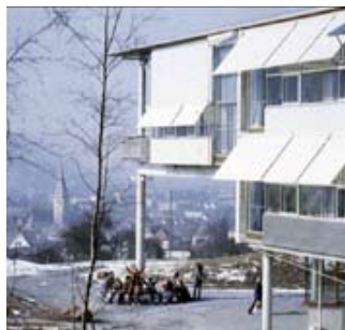
A könnyed megjelenésű lorch-i iskolaépület bejárat előtti zónáját a pillért körülölelő egyedileg tervezett széles körpad teszi “jó helyé” (Progymnasium Lorch, 1973)
