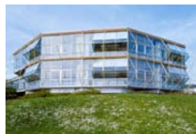
Az 1973-ban felépült lorchi általános iskola megjelenésének könnyedségét (az ötszög alaprajz ellenére) fokozza a vékony árnyékolószerkezettel rétegzetté tett és helyenként játékosan megmozgatott transzparens homlokzat.
