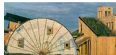
Peter Hübner a '60-as évek új technológiáinak egyik úttörjeként műanyag rendszereket tervezett a Staudenmayer-nek, ezért volt tapasztalata a rendszerelvű építés gyakorlatának előnyei és hátrányai terén is. Az 1970-as évek végétől a Stuttgarteri Műszaki Egyetem építész karának tervezési tanszékén oktatott. Ekkor ismerte meg publikációinak köszönhetően Walter Segal munkásságát, és meghívta előadni Stuttgartba. Később Segal rendszere alapján kísérleti építményeket kezdtek el építeni a kampuszon. felmerült, hogy építsenek egy diákkotthont, melyben a tervezők, az építők és a kivitelezők is az építészhallgatók lennének. Mindenkit megváltoztatott az a folyamat, ahogy a diákok számára lehetővé vált kipróbálni és életre kelteni saját vízióikat. A Bauhäusle becenevű épületegyüttes (lásd a képen) a kialakult páratlan közösségi atmoszférája miatt azonnal a legjobb építész kollégium címét érdemelte ki, s ezt meg is őrizte diákgenerációk során keresztül 25 év után is. Ez a tapasztalat fordulópontot hozott Hübner életébe is, és a későbbi ifjúsági házak, diákszállók és iskolák tervezése során is elkötelezett maradt a participatív építészeti és a folyamat-orientált tervezés iránt.
