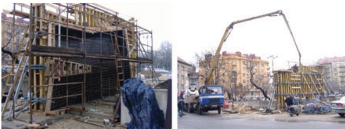
39. | A pavilon zsaluzása és betonozása (forrás: saját felvétel)
