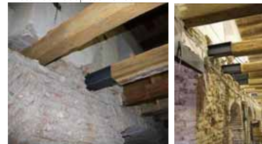
Protézisek beépítés közben
