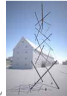
FUTURA-MagtárTensegrity Átértelmezett, lebegő rúdszerkezet: nyomott rudakból és húzott huzalokból
