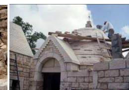
trulló építés közben
