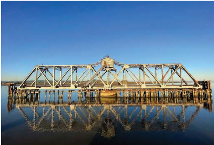
Black Point Railroad Bridge, USA, 1911, Újraépítve 2011-ben Fotó: wikipedia
