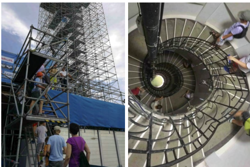
„Vizes város” BVM Építőtábor_ Vizes VB óriás műugró torony látogatás Madaras Koppány szerkezettervező és Kormos Szabolcs építész vezetésével; margitszigeti víztorony látogatás / 2017, saját fotó
