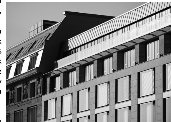
Riverpark irodaház Budapest, 2009 tervezés: Avant-garde Studio fotó: Frikker Zsolt
