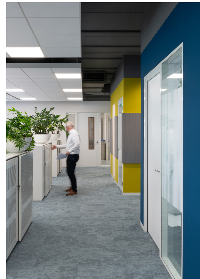
42. ábra: álmennyezeti szigetek csak ahol szükségesek
