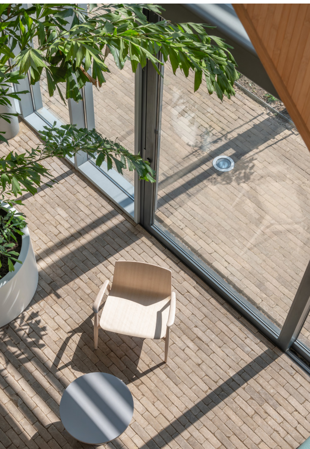
40. ábra: helyszíni beton nélküli földszinti padlóburkolat
