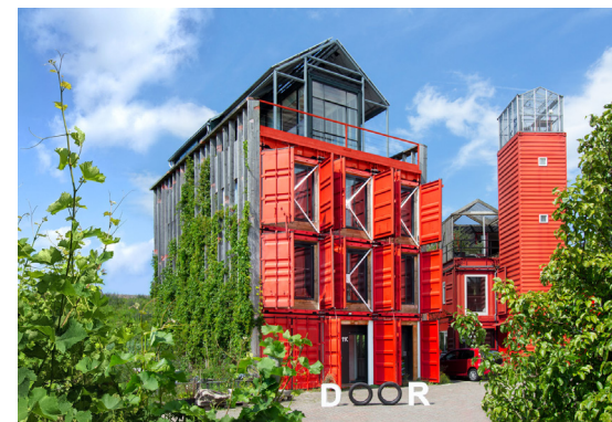
19. ábra: DOOR architecten, saját irodaépület, az ideiglenes épület 74%-ban újrahasznált anyagokból épült
