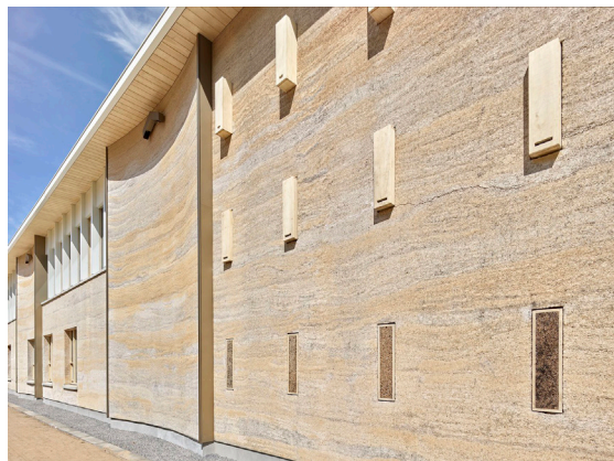
33. ábra: De Twee Snoeken, kenderbeton homlokzat mészkövel vakolattal a hollandiai Voorst városházán
