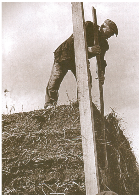
25. kép: rakott sárfal simára nyesése ásóval
