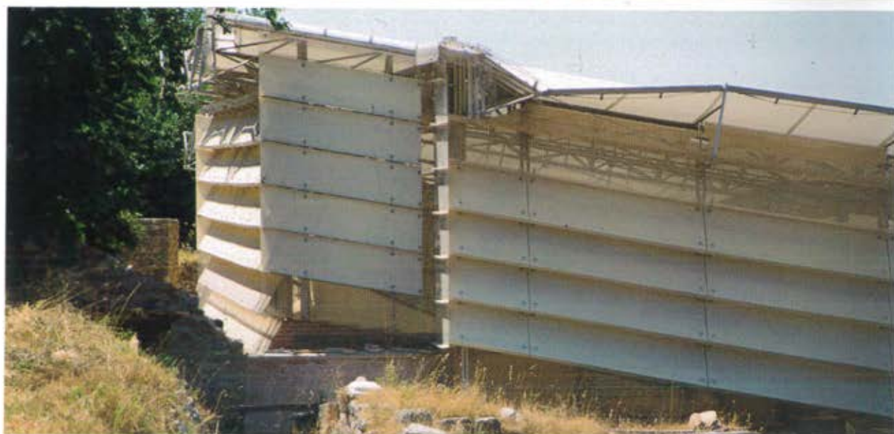
Selcuk/Ephesus (Törökország) Római épületek lefedése. Építész: Otto Häuselmayr, Wolfdietrich Ziesel /szerző felvételei/
