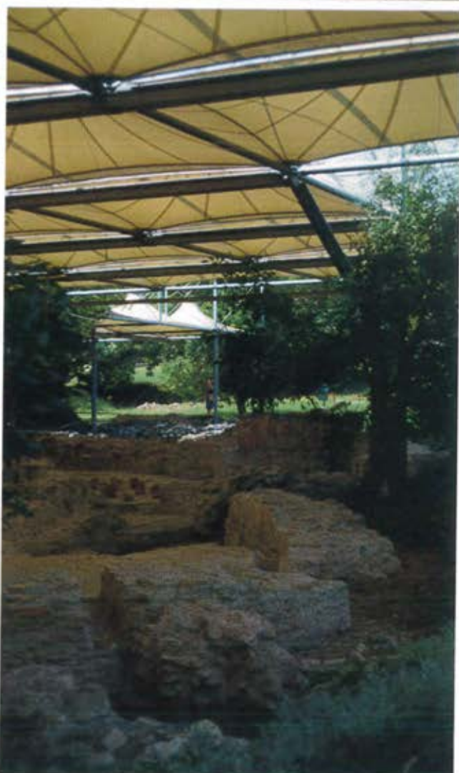
Desenzano del Garda (Olaszország) Római villa maradványainak lefedése védőtetővel /szerző felvételei/
