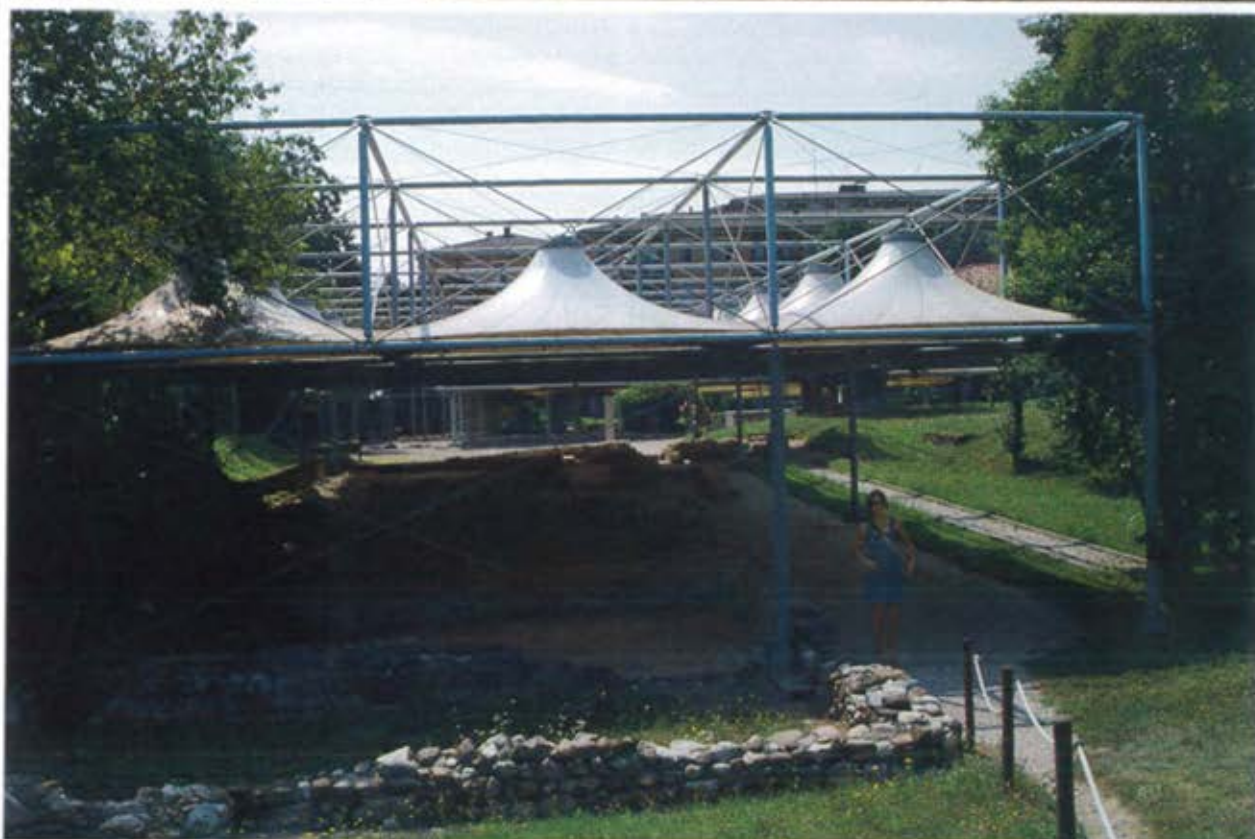
Desenzano del Garda (Olaszország) Római villa maradványainak lefedése védőtetővel /szerző felvételei/
