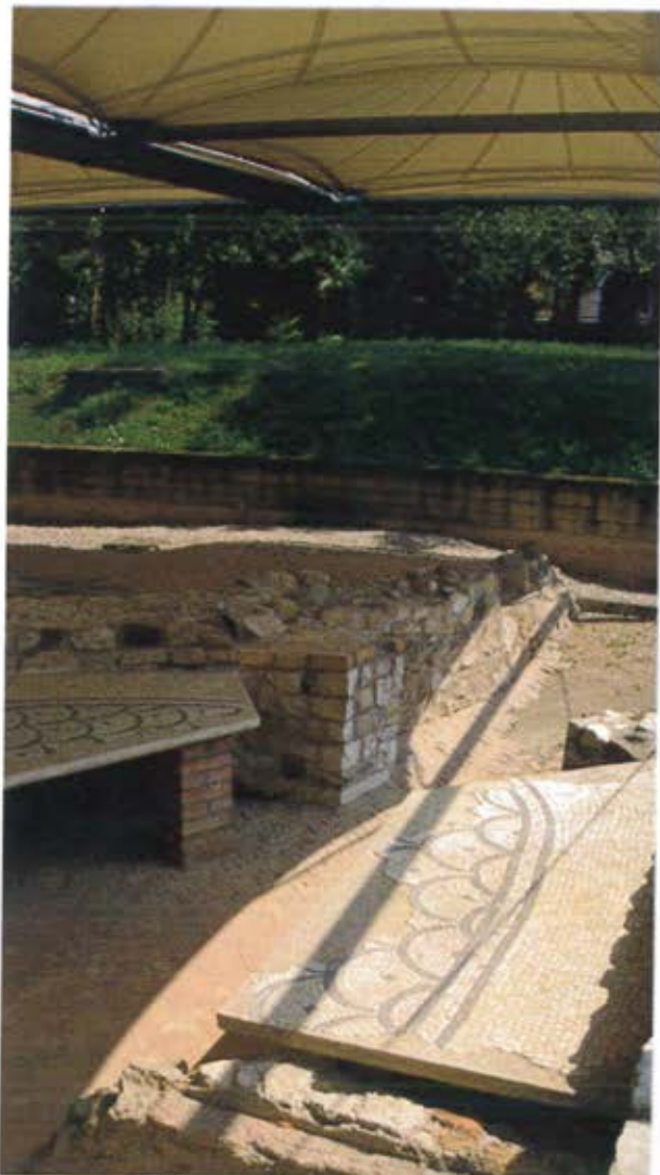
Desenzano del Garda (Olaszország) Római villa maradványainak lefedése védőtetővel /szerző felvételei/
