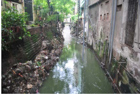
Csatornák közvetlen bekötése a folyóba 1.szakaszban
