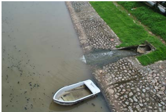
Gyűjtő satornák bekötése a folyóba 2.szakaszban
