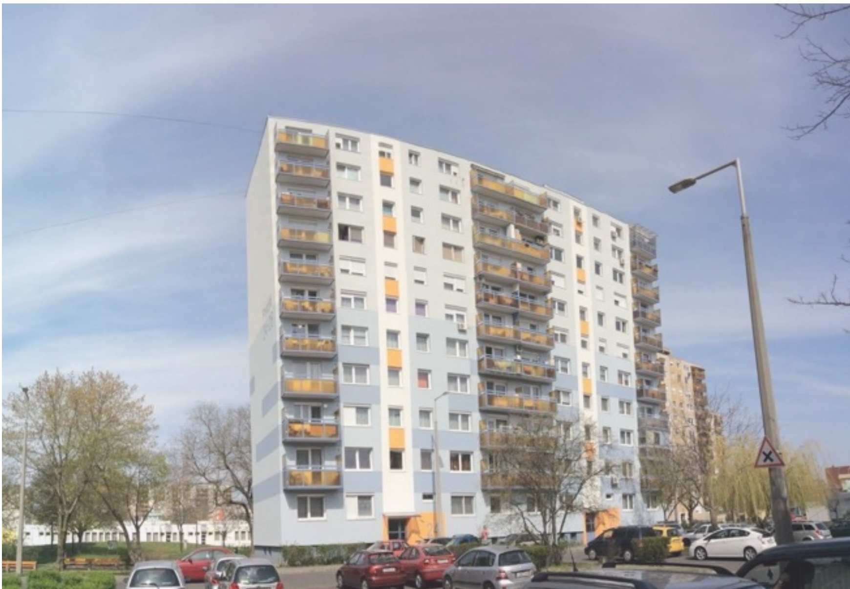
a keret egyik épületének felújítása a Panel-program keretén belül (Petőfi Sándor u. 24-26.) nyílászárócsere, homlokzat- és tetőszigetelés, fűtőkorszerűsítés
