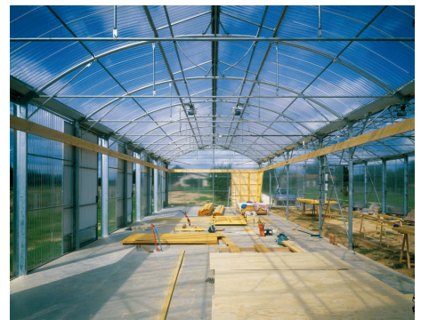
46. Lacaton & Vassal: Lakóház, Coutras építés közbeni állapot
