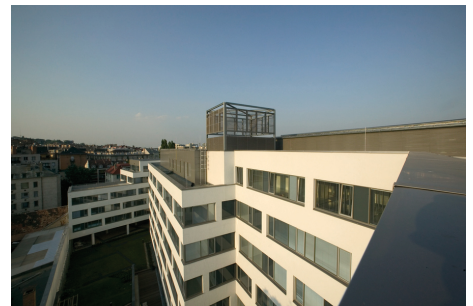
90. VOC irodaház, Budapest II. Kapás utca, udvari homlokzat
