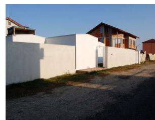
1. ABRUPTARCHITECTURA (Cosmin Pavel, Cristina Constantin) Bragadiru-i (RO) családi ház előregyártott garázsok felhasználásával (2013)
