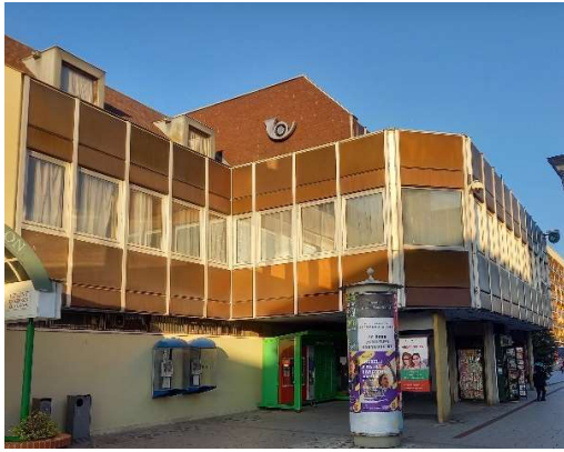
60. A Veszprém központjában elhelyezkedő, Ruttkay Gyula által tervezett posta épület (2022)
