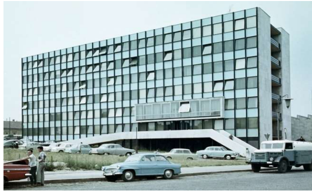
19. A párház keleti homlokzata a megépülését követően
