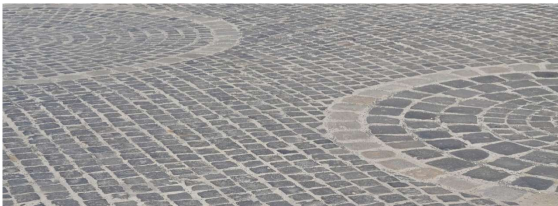
44. A veszprémi rehabilitáció során felbontott és visszaépített, meglévő bazalt kockakő burkolat
