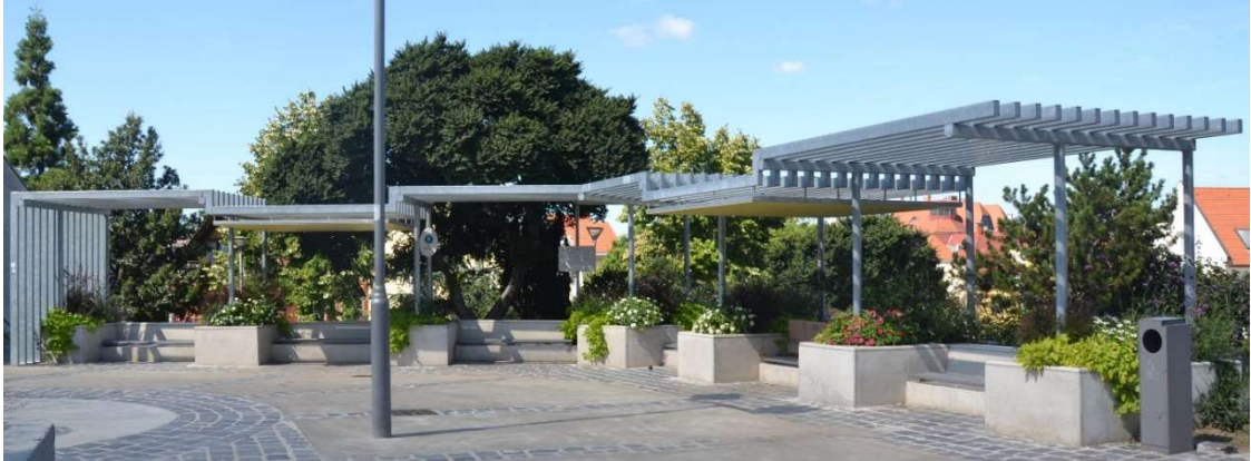
45. Az eredetileg fa szerkezetű pergola helyén, új, acél szerkezetű pergola készült
