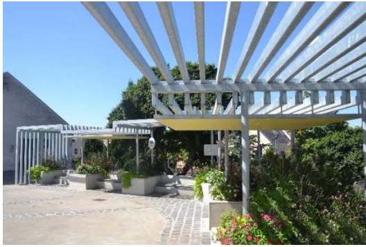
46. A belváros rehabilitáció I/B. üteme során készült pergola
