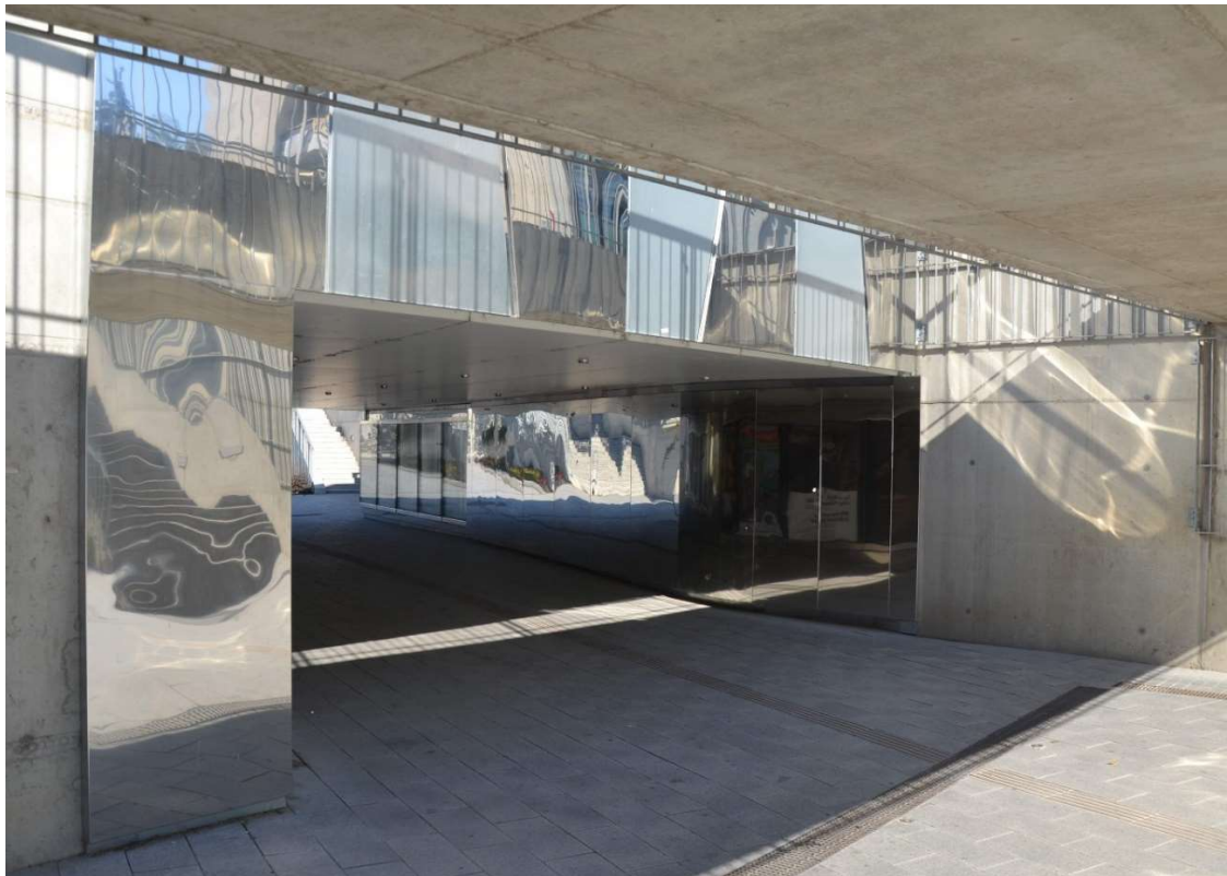
3. A veszprémi városközpont rehabilitáció keretében átépült aluljáró
