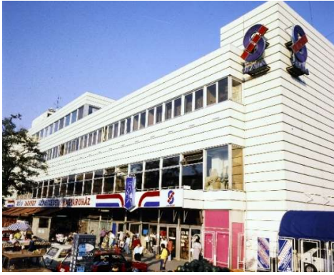
62. A budai Skála épülete 1986-ban
