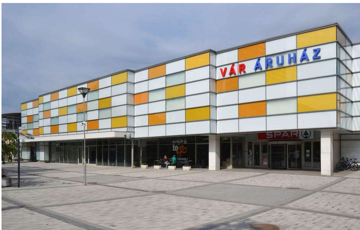
A Vár Áruház a felújítás után
