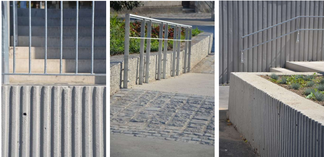
33. Veszprém központjában meglévő, a rehabilitáció keretében felújított beton támfalak
