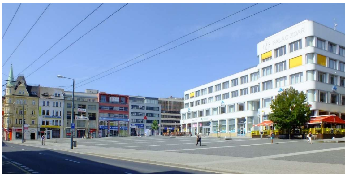
8. Ústí Nad Labem főterét a rehabilitációt követően egységes téralakítás és anyaghasználat jellemzi
