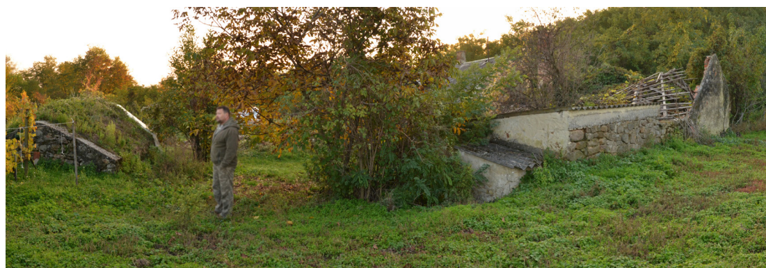
39.ábra_VáliBor Fogadó és vendégház, átépítés előtti állapot, északi oldal – 2015. november (saját fotó)
