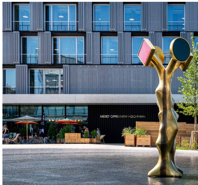
28 | Herzog & de Meuron: Meret Oppenheim Hochhaus / MOH, Bazel, 2013-2018. [7,00], illetve Meret Oppenheim: La Spinale című szökőkút szobra, melyet a köztérrel együtt a többlettérték-illetékből finanszíroztak
