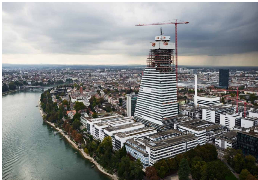
15 | Herzog &amp; de Meuron: Roche Bau 1, Bazel, Svájc, 2009-2015. [14,00]
