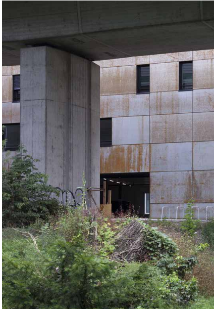
42 | Schneider Studer Primas Architekten: Wohnareal Zwicky-Süd, Zürich-Dübendorf, 2016. [2,10]
