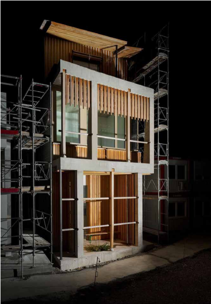
41 | Herzog & de Meuron: Gyermekkörház, Zürich, homlokzati „mockup”, 2014. [2,90]
