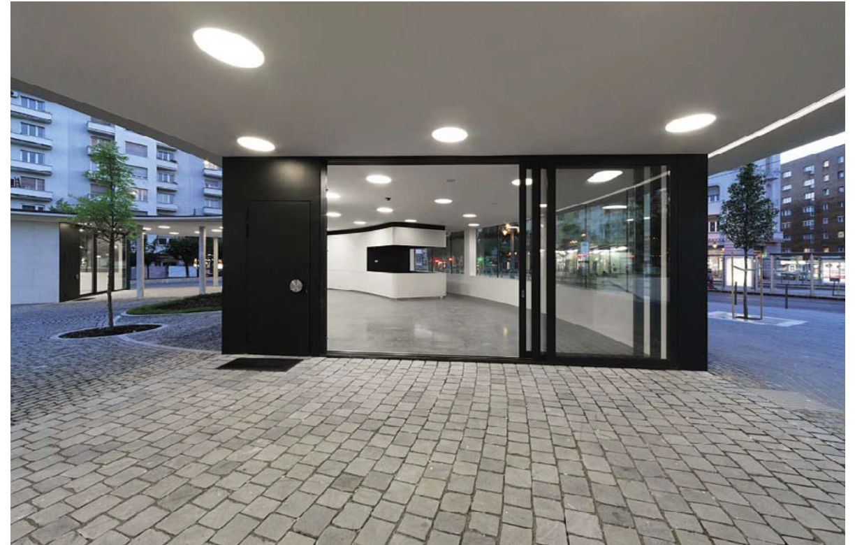
Az eredeti osztott üvegtáblák és mellvédek helyett finombeton felületek és íves üvegtáblák
