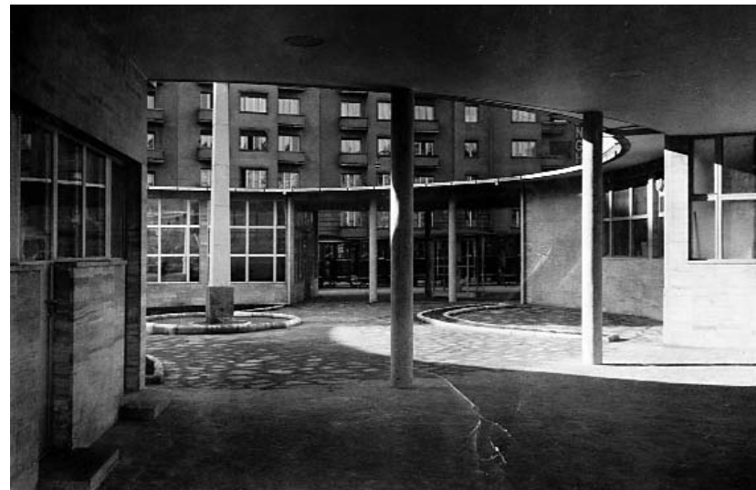
Átjáró az éttermi épület és a műhely épület között. Marsovszky Eleménné felvétele 1942.
