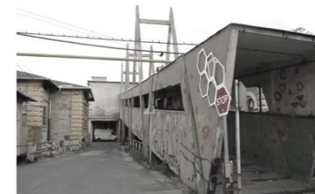
ÁLLAPOT SZERKEZET JÓ, VEGYES TETŐ KARBANTARTVA HOMLOKZAT ROSSZ GÉPÉSZET MŰKÖDŐKÉPES
