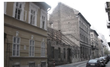
ÁLLAPOT (HOSTEL JÓ, KÖRNYEZET ROSSZ) SZERKEZET JÓ, VEGYES TETŐ FELÚJÍTVA, ILL. HIÁNYZIK VAKOLAT JÓ, ILL. HIÁNYZIK GÉPÉSZET MŰKÖDŐKÉPES
