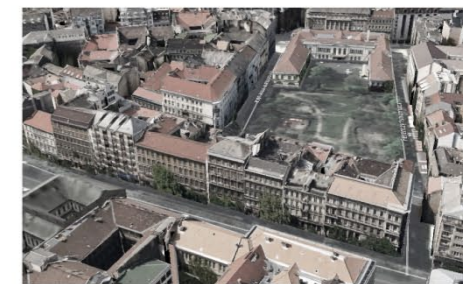
ÁLLAPOT SZERKEZET ROSSZ, VEGYES TETŐ KARBANTARTVA HOMLOKZAT ÁLLVÁNYOZVA GÉPÉSZET MŰKÖDŐKÉPES
