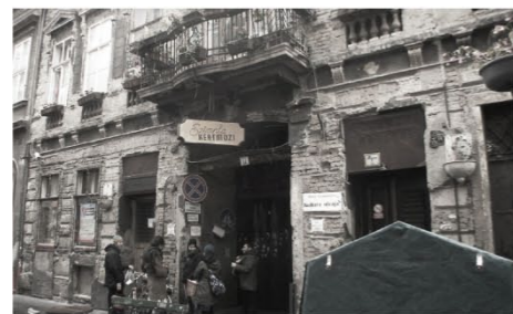
ÁLLAPOT SZERKEZET JÓ ÁLLAPOTBAN TETŐ FELÚJÍTVA VAKOLAT HIÁNYZIK GÉPÉSZET MŰKÖDŐKÉPES
