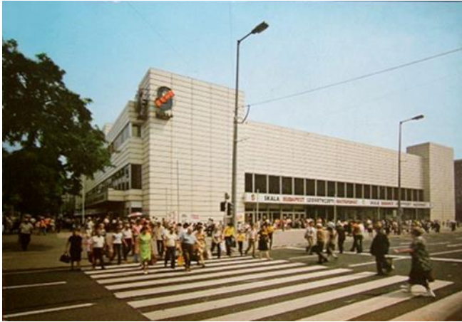
A Budai Skála épülete
