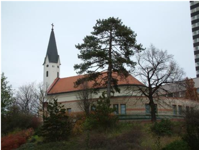
A Veszprém központjában elhelyezkedő evangélikus templom Ruttkay féle bővítése
