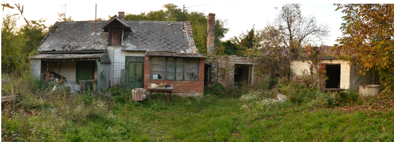
(9) Válifogadó épülete az átépítés előtt - keleti oldal, 2015. október (saját fotó)
