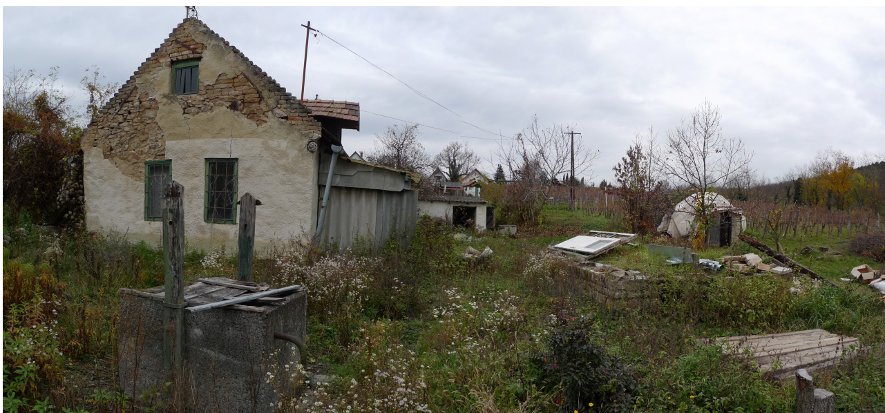
(8) Válifogadó épülete az átépítés előtt – északi oldal, 2015. november (saját fotó)
