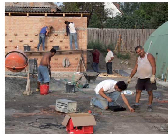
Biobrikett-szárító építés, Monor 2014 —saját fotó
