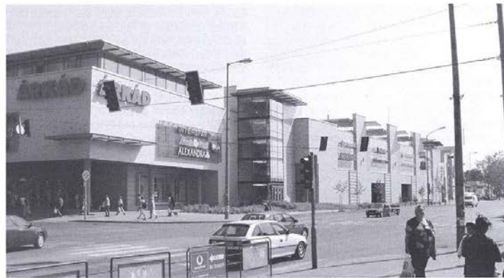
Homlokzat és tető, tégl és fém találkozása a Nagy Lajos király útja felőli homlokzaton
