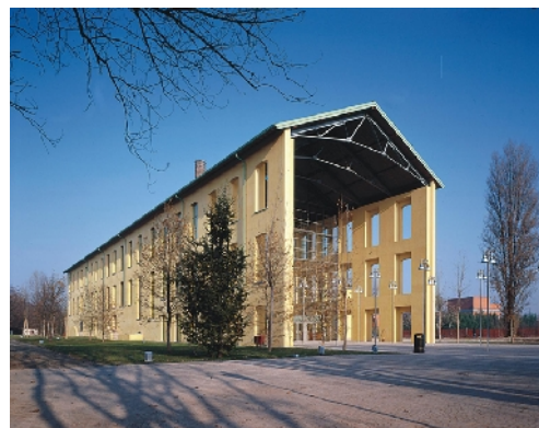
24. kép A „kirobbantott” homlokzat (Forrás: Fondazionerenzopiano.org)
