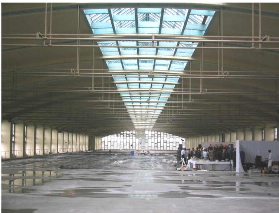
10. kép Az üzem belső képe az átépítéskor (Forrás: Építészfórum.hu)
