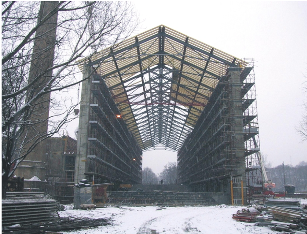
23. kép A tartószerkezeti megerősítés közbeni állapot (Forrás: Fondazionerenzopiano.org)
